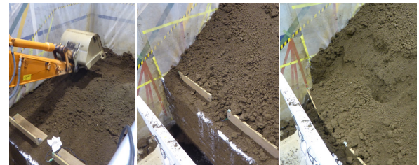
3) 建設機械で盛土2を行う様子 4) 盛土2が終了し崩壊を待つ様子 (崩壊前) 5) 土壁が崩壊して擁壁に作用した様子
