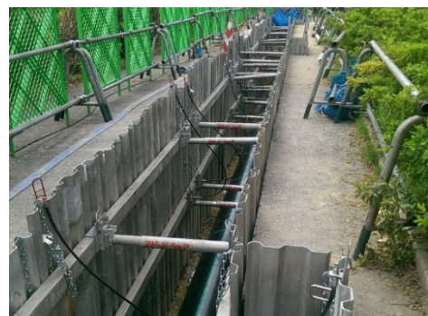
図 10 既往の土止め支保工 (矢板工法) の例
