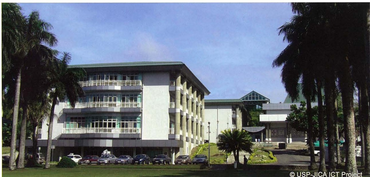
写真1. USP 南太平洋地域のICT拠点となるJapan-Pacific ICTセンター
