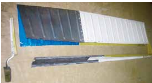
(a) 修理した外板および桁
