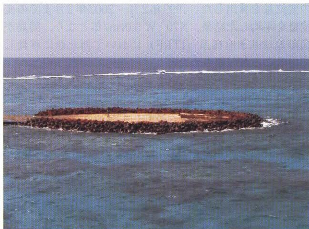
写真-5 観測所基盤 (旧灯台跡)
