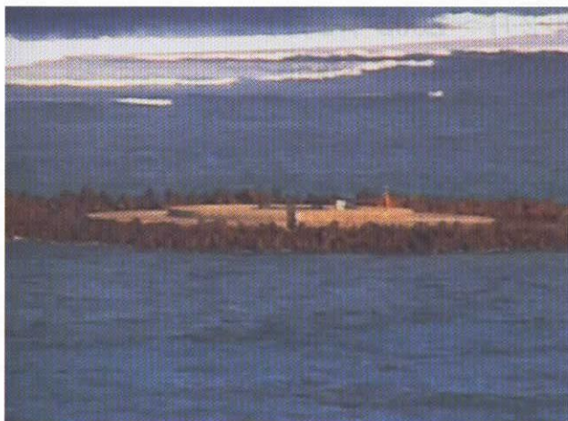
写真-2 東小島 鉄製消波ブロックとコンクリートで保護されている。
