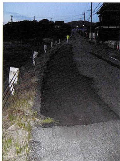
写真-3 海側（写真左）への地表の変形を示す道路上の亀裂の補修跡
