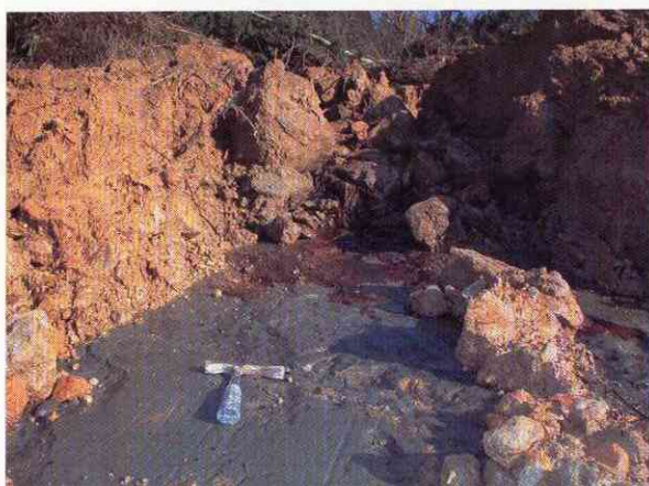
写真-7 東竹沢地すべりのすべり面
