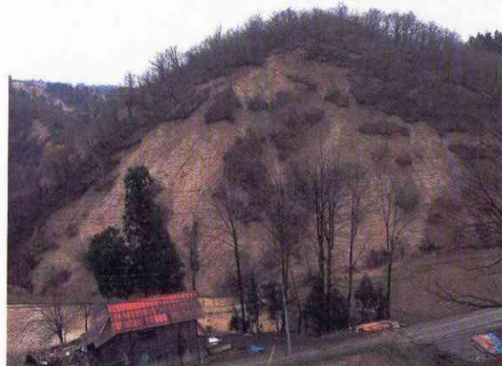
写真-2 崩壊B
