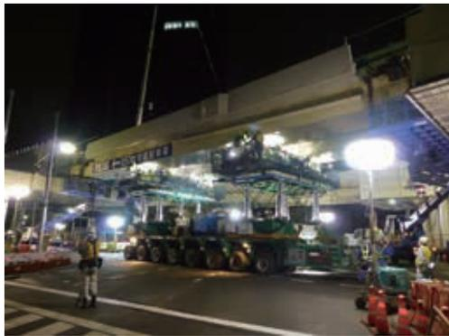
第 7 図 多軸台車による桁受替え状況
