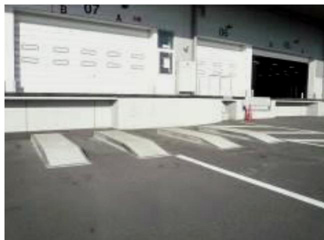
図 9-3 トラック用プラットホーム高さ調整台<sup>注2)</sup>
