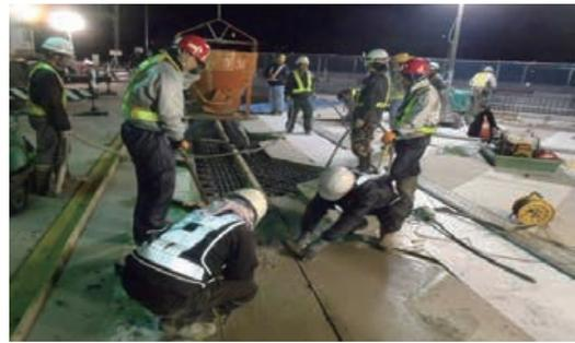
第 17 図 現場打ちコンクリート打設状況
