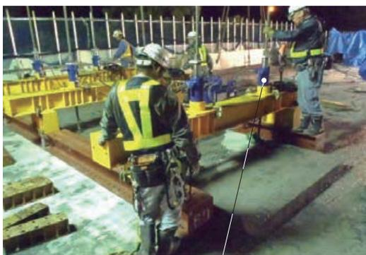
第 13 図 剥離装置による既設 RC 床版の撤去
