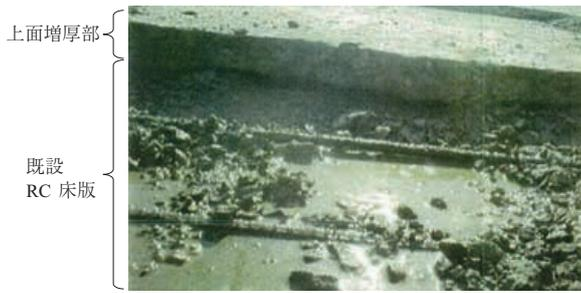
第 2 図 RC 床版コンクリートの砂利化
