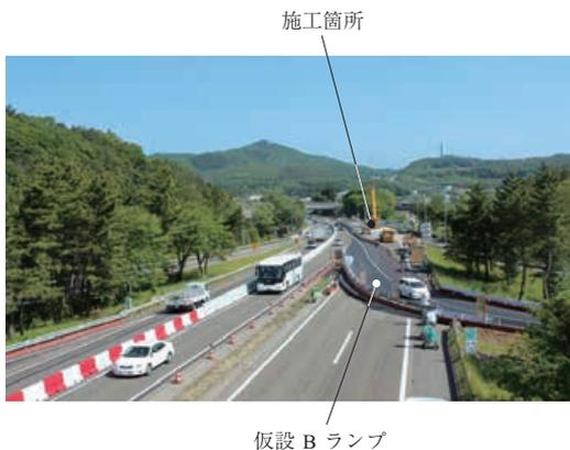
第 12 図 RC 床版取替時の交通規制 (ステップ 4)
