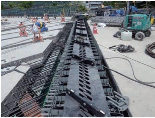
第 16 図 桁端部の PCa 床版敷設状況
