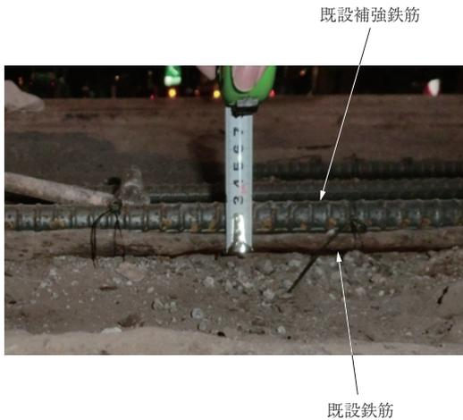
第 3 図 断面欠損した既設鉄筋と既設補強鉄筋
