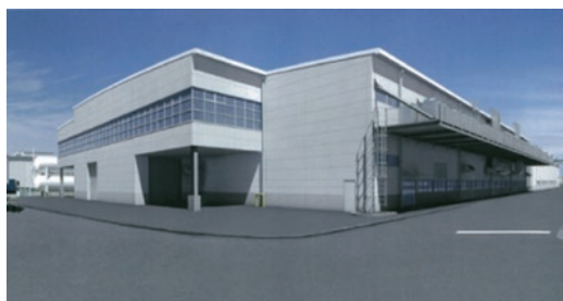
第 22 図 相馬第一工場第 5 加工棟 Fig. 22 Soma 5th building at No. 1 Works
